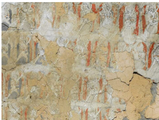
图六 壁画颜料层脱落
