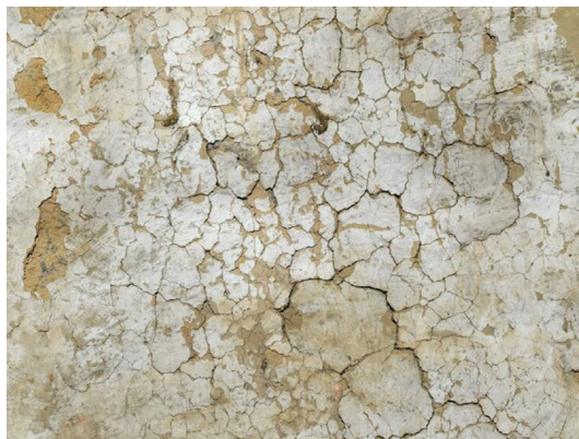
图五 收缩缝隙
