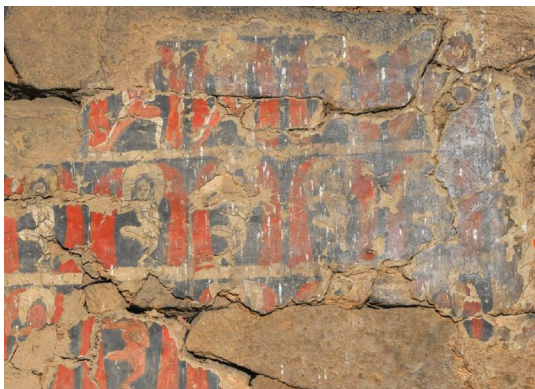
图四 结构性裂隙
